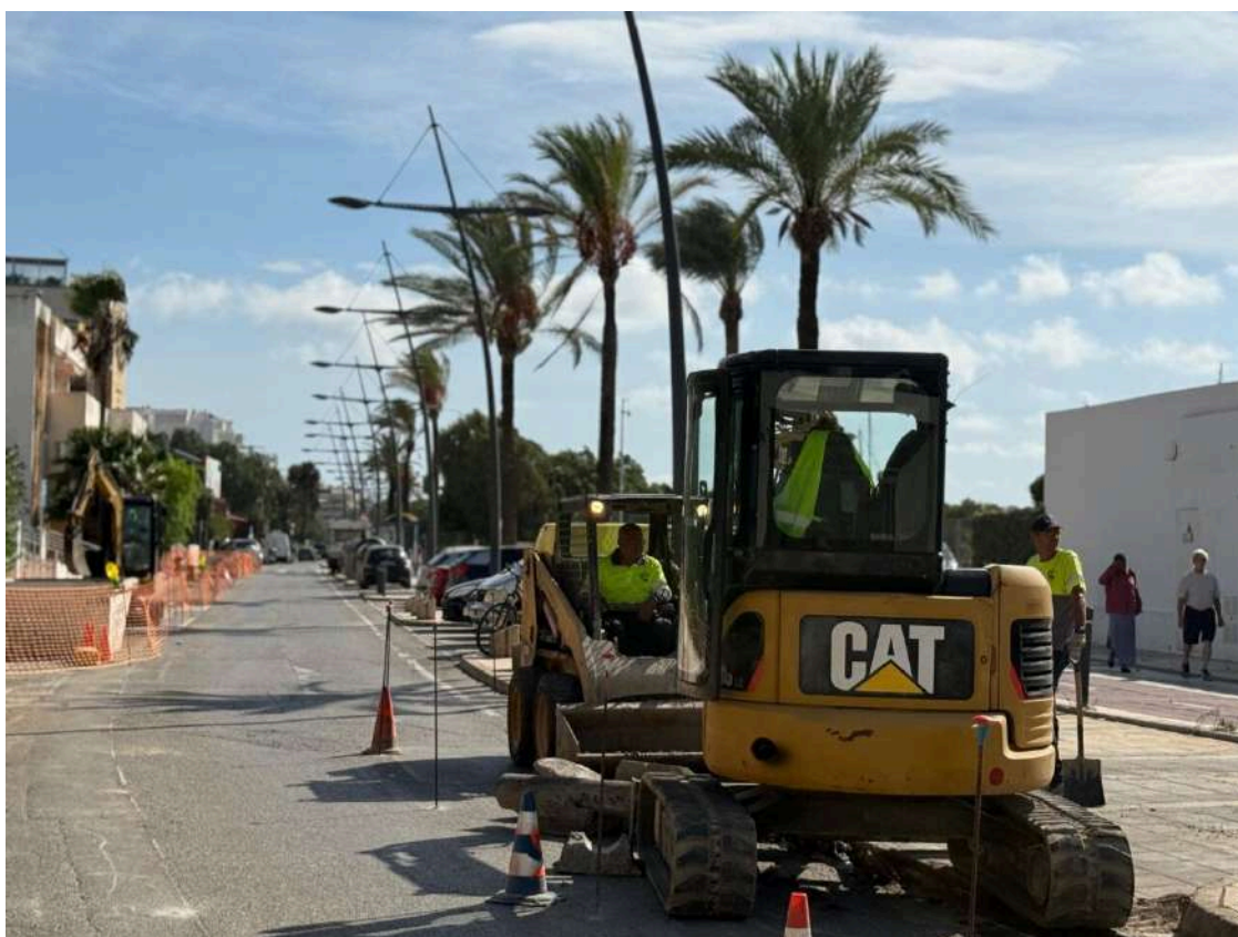
Obras de mantenimiento y mejora de las instalaciones hidráulicas en la ciudad de Ibiza.
