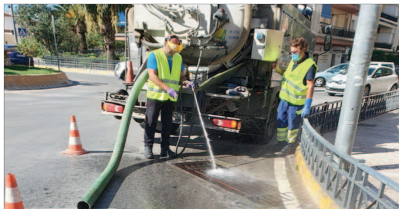
PREVENCIÓN. Operarios trabajan en el mantenimiento de uno de los imbornales de la ciudad.
